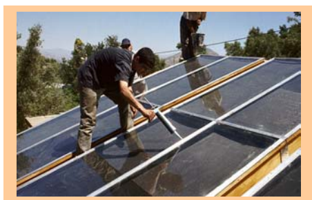
Photo 11 : Montage des panneaux solaires
